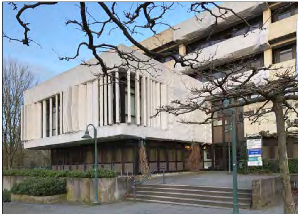
Die prägnante Fassade des Sitzungssaales öffnet sich zur Stadt.
