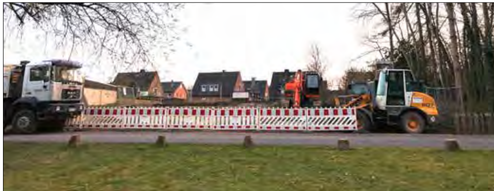
Für die Kita am Fürstendiek beginnen bereits die Arbeiten.
