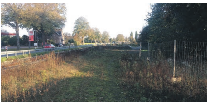
Ehemaliges Gleisbett der Frachtrampe Raestrup
